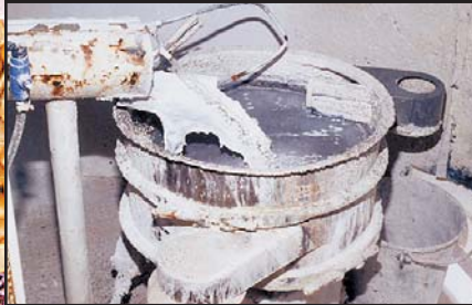
F. Lime slurry
